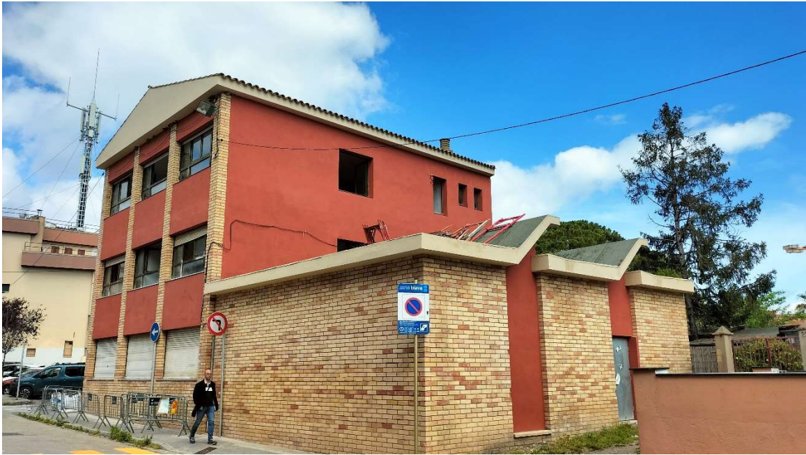
Façanes est i sud
