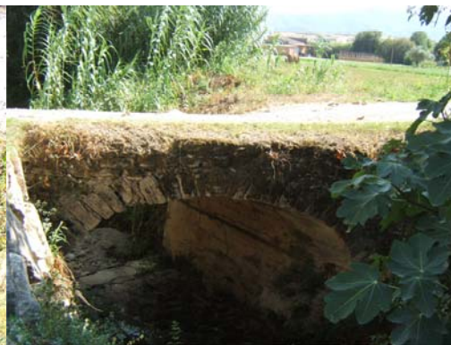
5. PONT DE CAN BOADA - ALÇAT NORD
