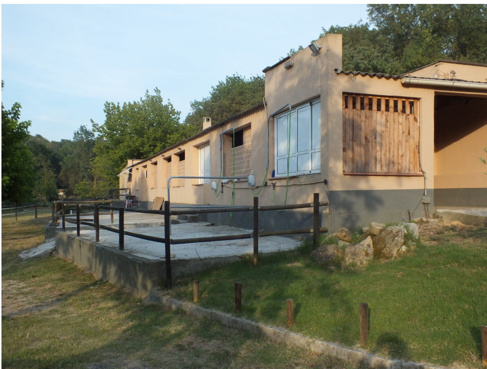
Fotografia 2. Vista de la façana nord i oest de l'edifici principal des de dins la finca..
