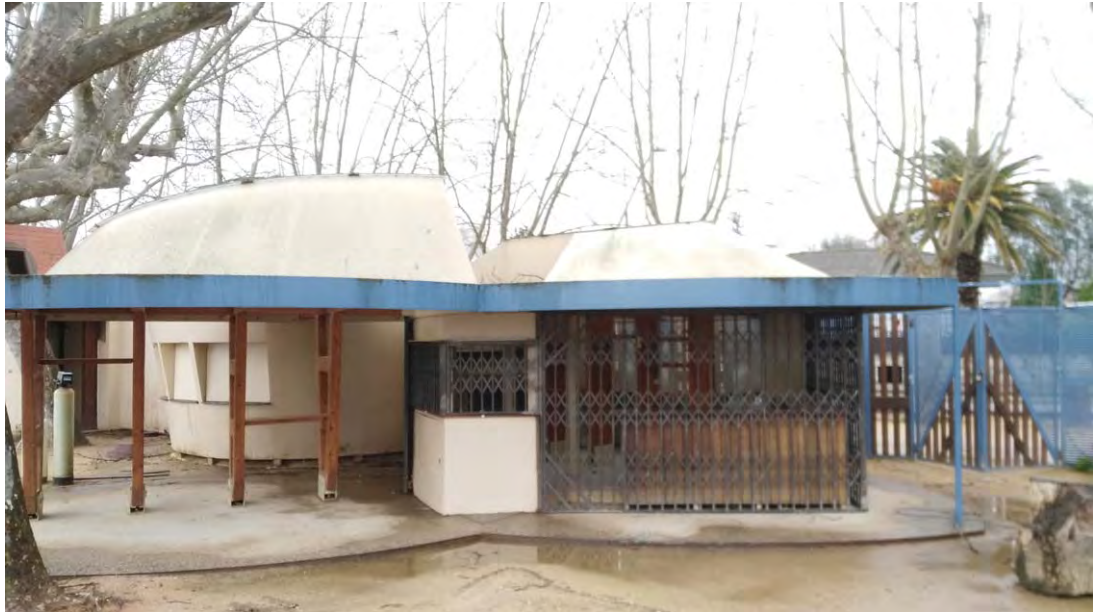
Barra i tancaments metàl·lics actuals.
