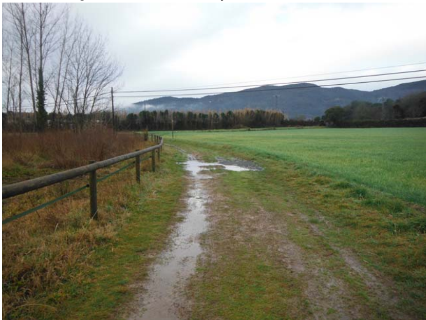
Imatge 12. Estat actual del traçat del nou camí en el tram 3
