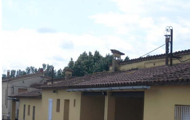
Detall instal.lacions coberta
