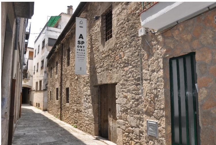
Vista de la façana de l'edifici
