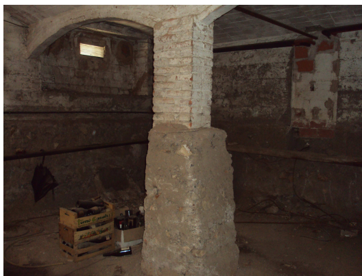
foto del pilar estructural a substituir pel pòrtic plantejat.
