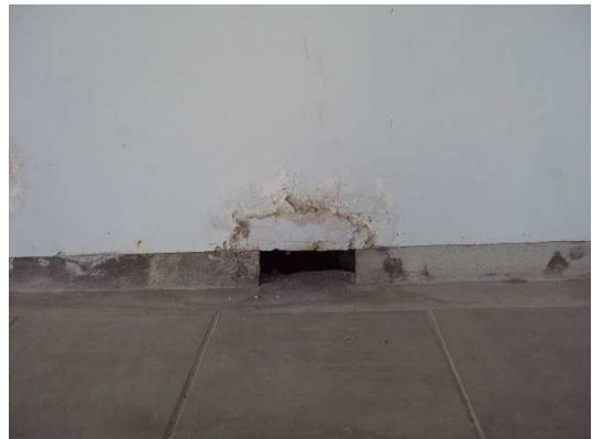
Sòcol i ventilacions.
