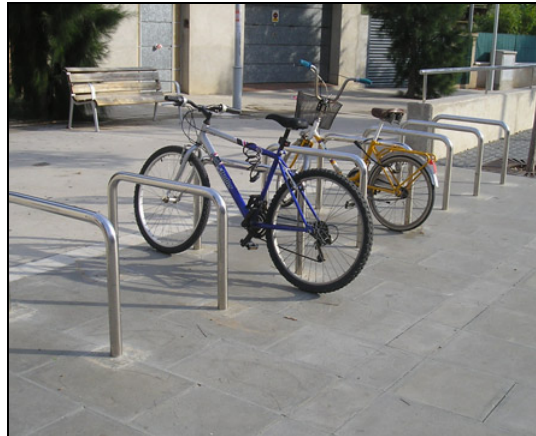
Imatge 8.3.2.- Exemple d'aparcament per a bicicletes tipus "U" (Font: web Ajuntament Tordera).
